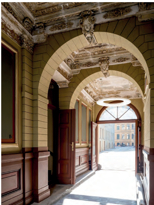
Auch an der Decke in der Tordurchfahrt wurde die historische Farbfassung freigelegt, während Wände und Bögen dem Farbfund entsprechend einen neuen Anstrich erhielten.
