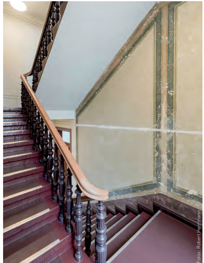
In dem Projekt „Neue West“ des Büros AHM Architekten wurde der historische Farbanstrich der Wand bis zum ersten Treppenhausepodest freigelegt.
